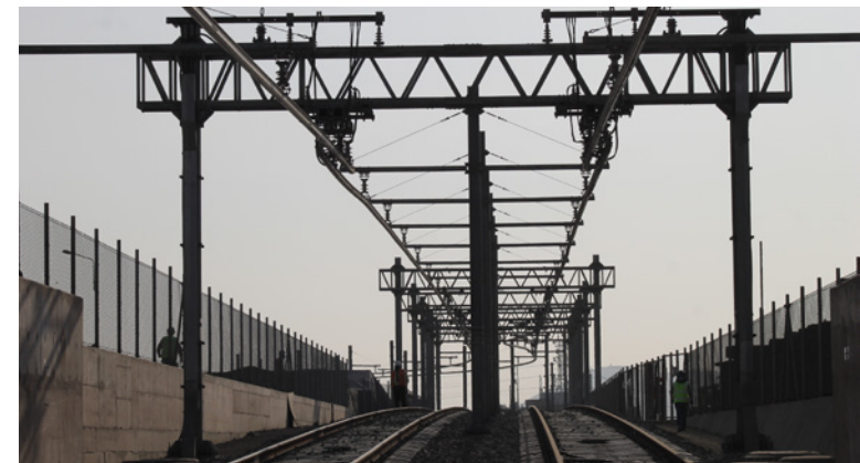
Línea 2 y ramal línea 4 metro de Lima (Perú).
