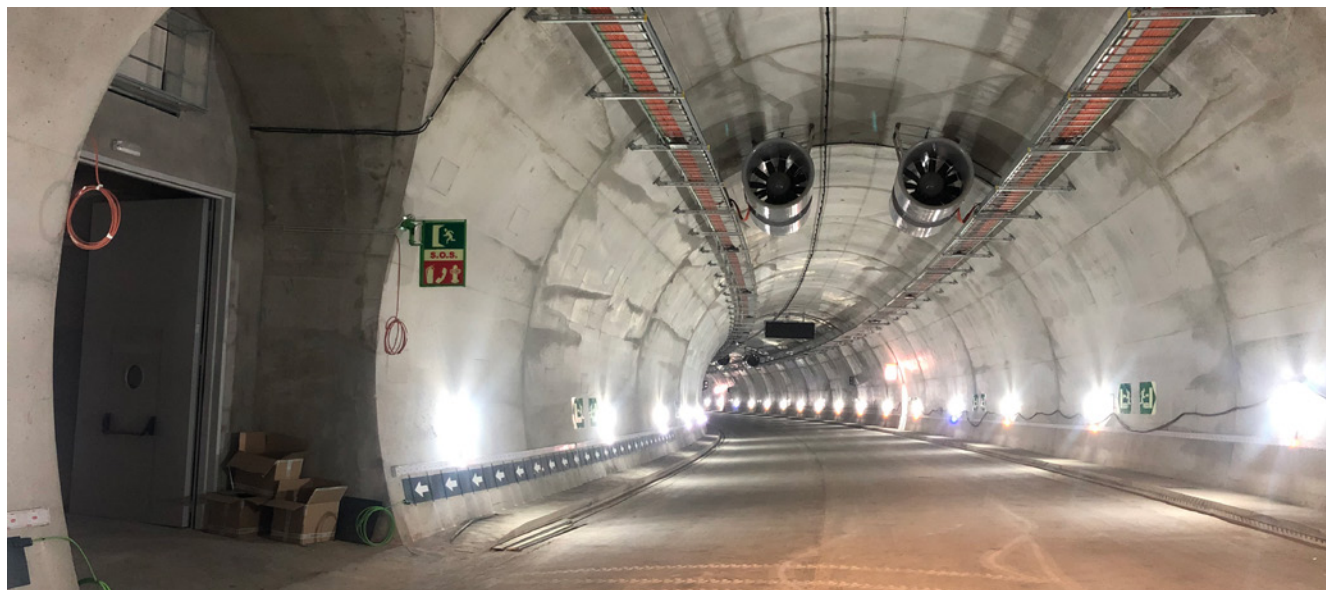
Túnel de Vallirana, Cataluña (España).
