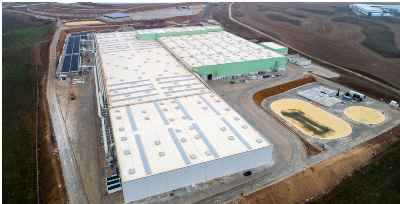
Centro de Tratamiento de Residuos en Loeches, Madrid (España).
