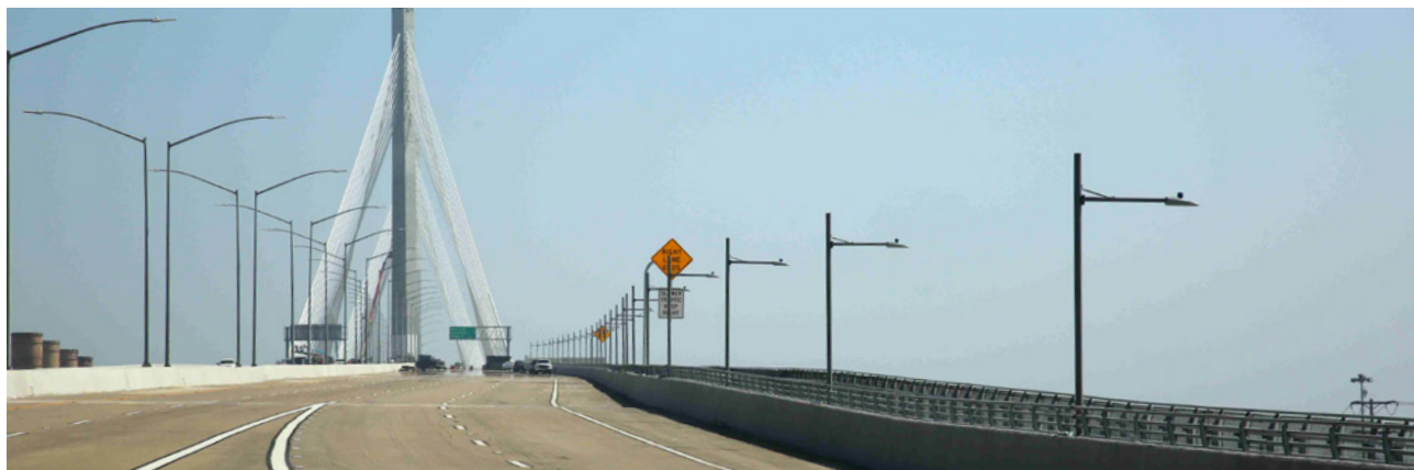
Gerald Desmond Bridge, Los Ángeles (EE. UU.).
