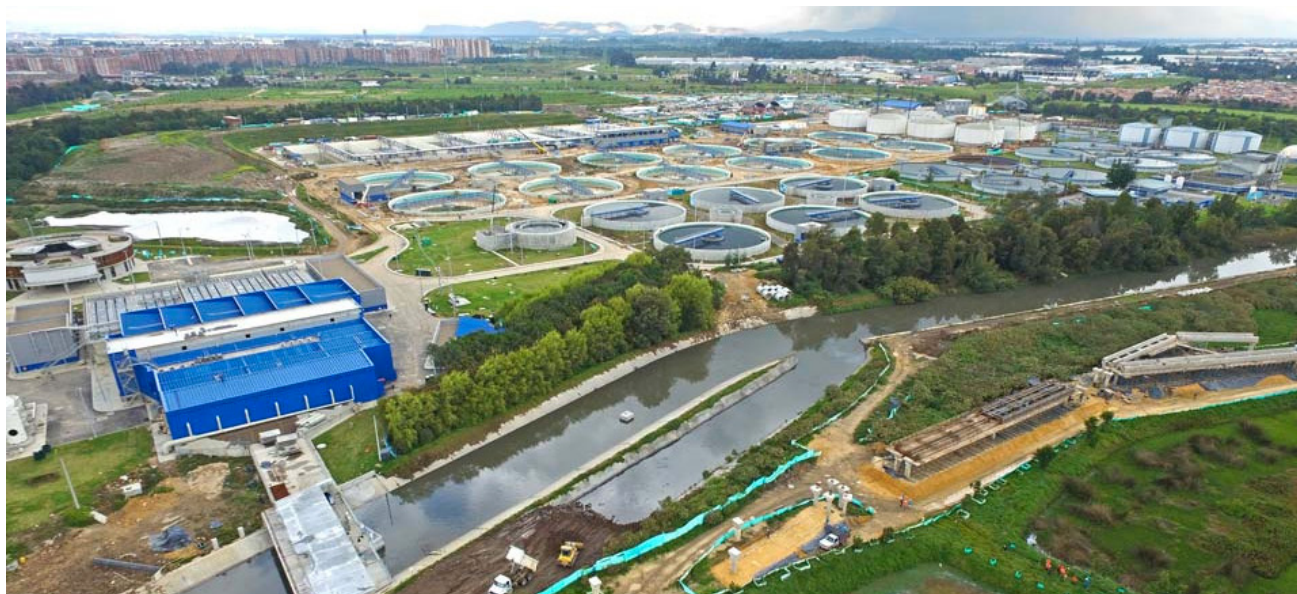
Planta de Tratamiento de Aguas Residuales (PTAR) El Salitre, en Bogotá (Colombia).
