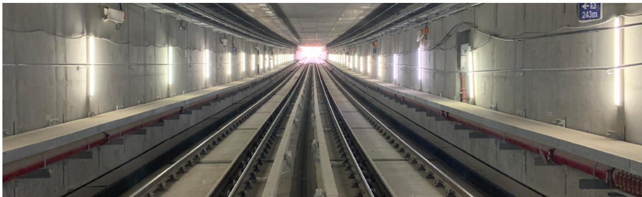
Línea 2 y ramal línea 4 metro de Lima (Perú).
