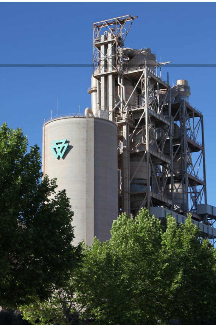
Torre de precalcinación. Fábrica El Alto, en Madrid (España).
