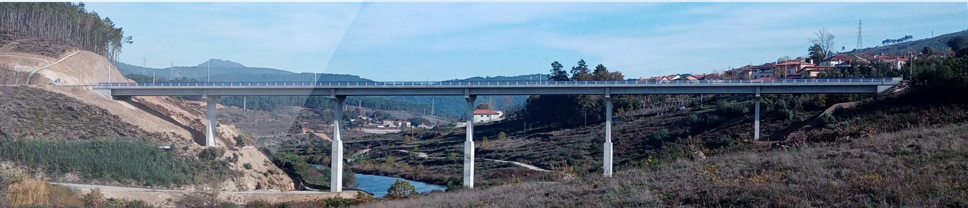
Puente Tamega (Portugal)
