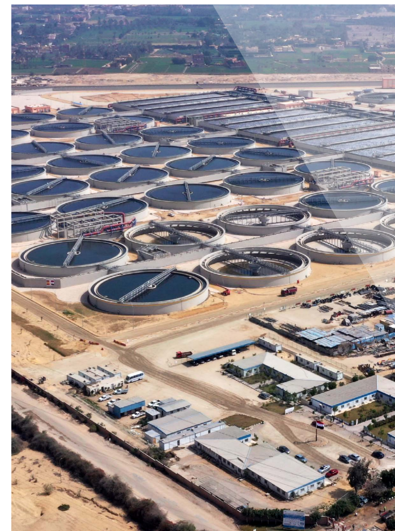
Planta Tratamiento de Aguas Residuales Abu Rawash (Egipto)
