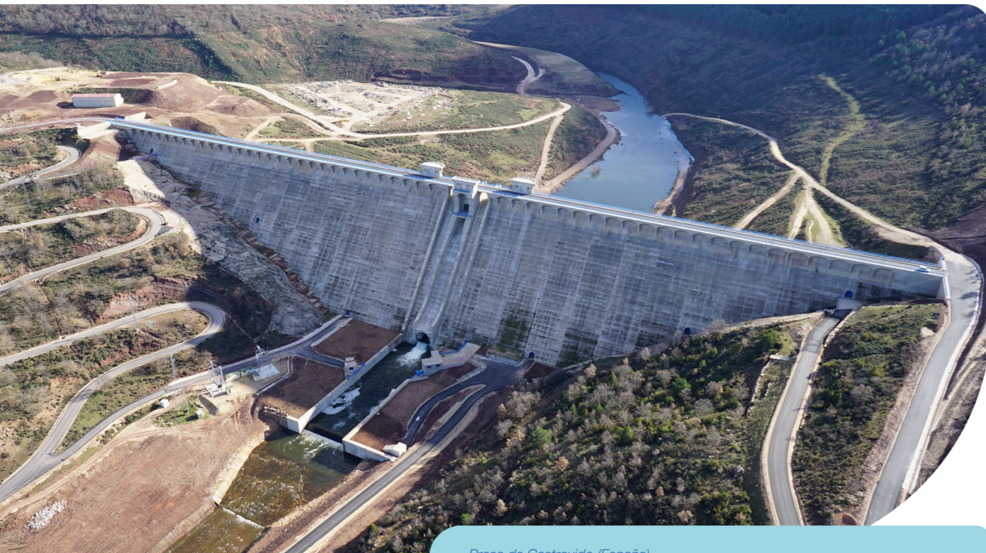
Presa de Castrovido (España)
