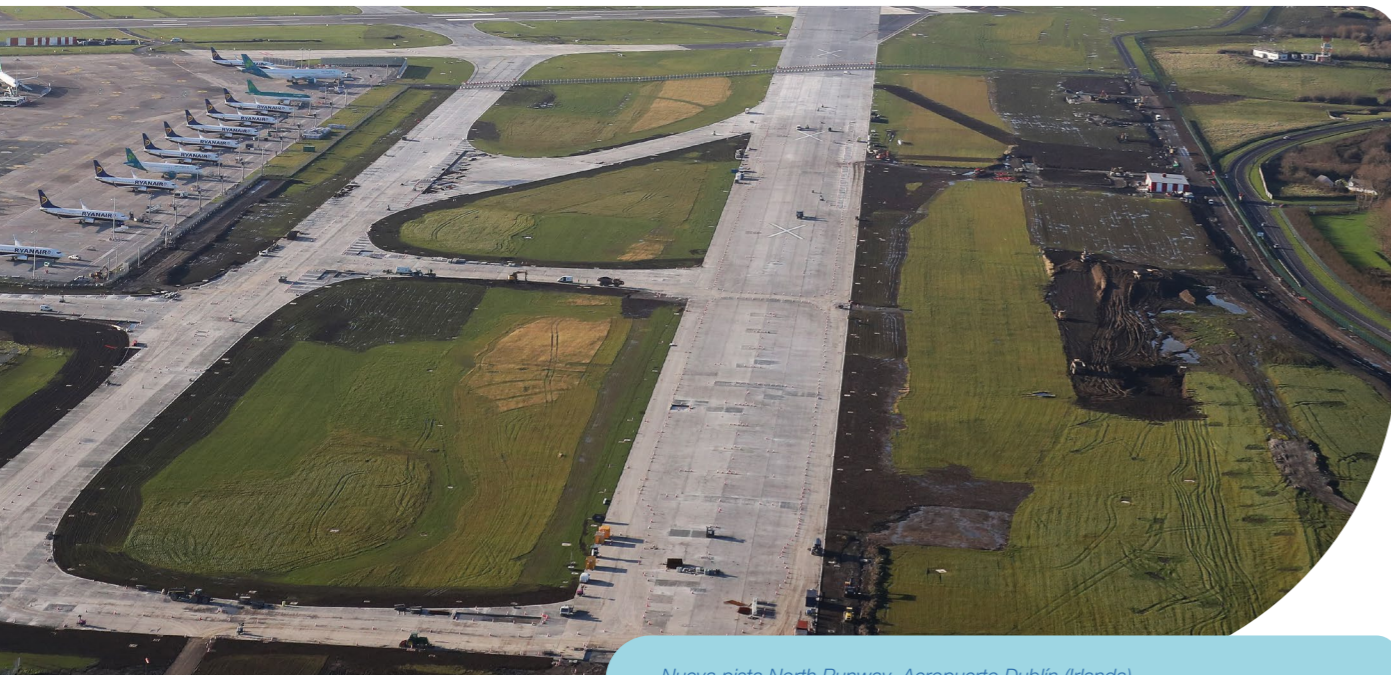
Nueva pista North Runway, Aeropuerto Dublín (Irlanda)
