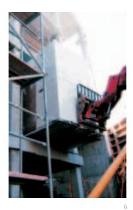
6.- Los aseos, cuya estructura consiste en un entramado de tubos de acero galvanizado revestido por tableros ligeros, se colocan en obra directamente traídos desde la fábrica con los acabados finales.
